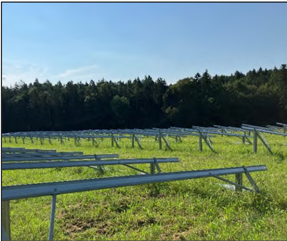
Befestigung durch Rammen
